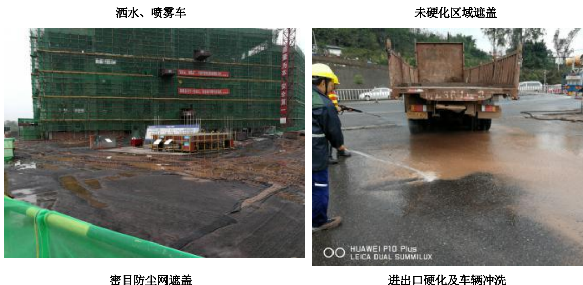
图 4-2 施工区大气污染物防治措施
