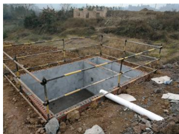
施工营地化粪池
