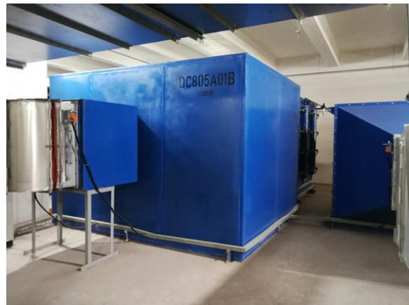
图 3-3 整理车间含尘废气处理装置图
