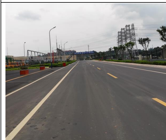
道路广场区路面
