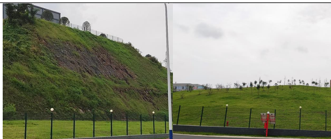
厂区外边坡工程绿化
