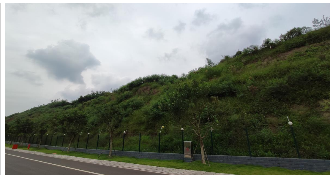
厂区外边坡工程绿化
