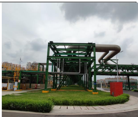
建构筑物区绿化和盖板沟
