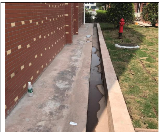
建构筑物区混凝土排水沟
